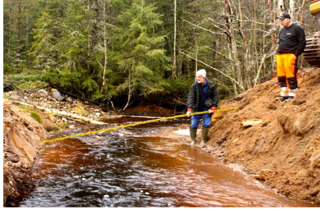
Mätning av vattendraget för att se att trumman kommer passa. Foto Cecilia Larsson
